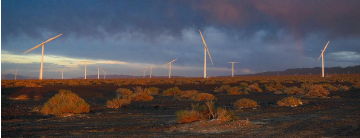
Abbildung 1: SCD 3MW Turbinen
